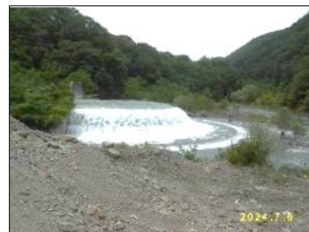
土砂バイパス吐口 一見噴水？
