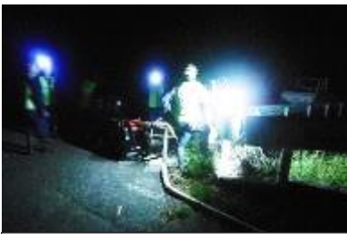
防災川路は可搬ポンプで中継送水
