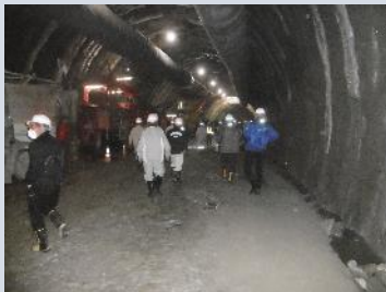
トンネル先端へ向かいます
