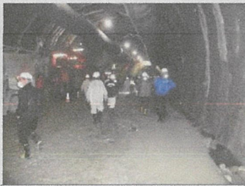
トンネル先端へ向かいます
