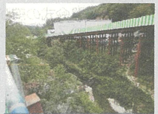
松川に架けた仮設橋
