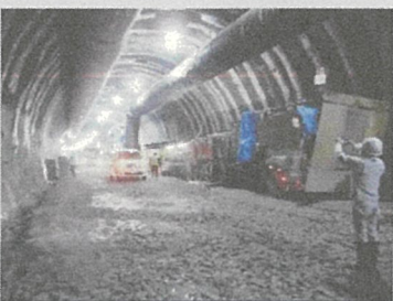
トンネル先端から入口を望む
