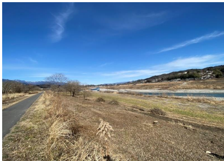
天竜川上流河川事務所による河川敷樹木伐採作業
