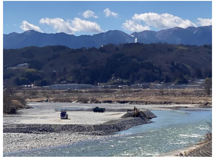
久米川合流地点上流のしゅんせつ作業
